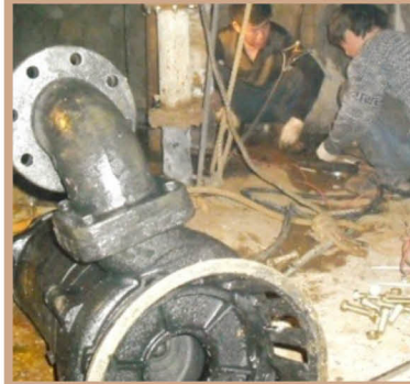
올림픽기념관 수중펌프 설치
