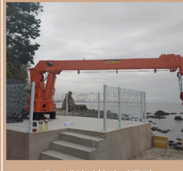
백수 백암선착장 다목적 인양기 제작설치
