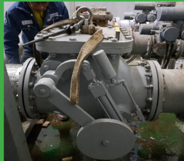
신대 지하차도 체크밸브 정비공사
