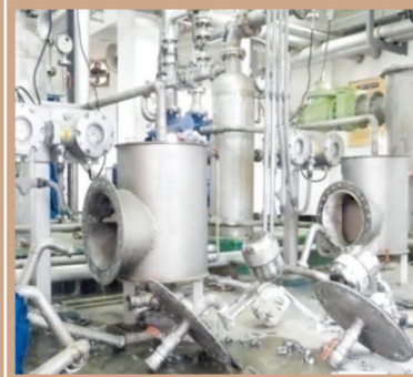
순천하수처리장 교반용 배수밸브 설치
