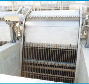
로타리스크린 제작 설치
