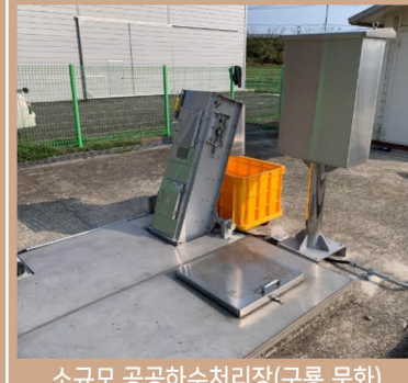
소규모 공공하수처리장(구룡, 문화) 스크린 및 교반기 설치공사-관급자재 (미세목스크린)
