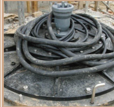
정원박람회 펌프 설치
