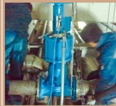
순천하수처리장 슬러지 유입밸브 설치
