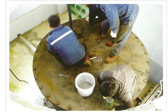
풍덕 제1배수펌프 모터권선 정비
