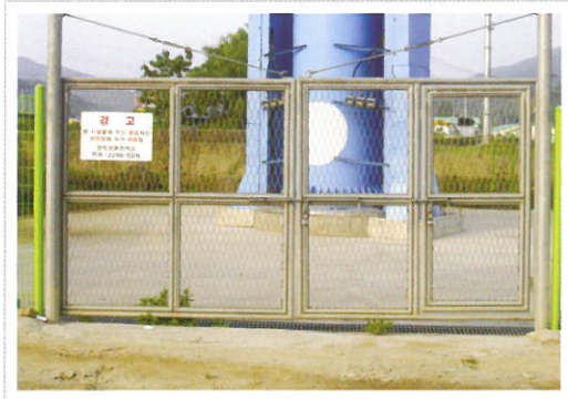
출입문 & 철제계단, 사다리
